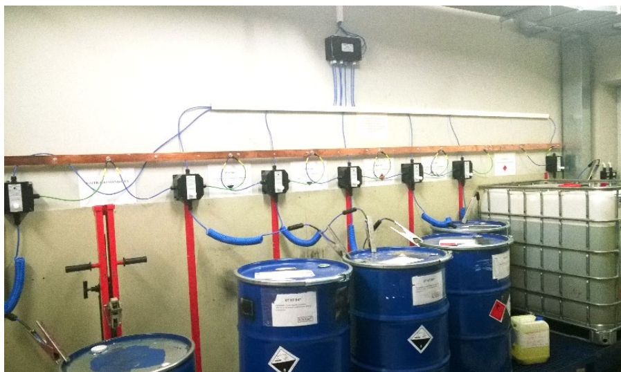
Przykład zastosowania systemu Bond-Rite zasilanego z sieci do uziemienia metalowych beczek o pojemnościach 200 l i zbiorników IBC o pojemnościach 1000 l, w których przechowywane są środki łatwopalne.
