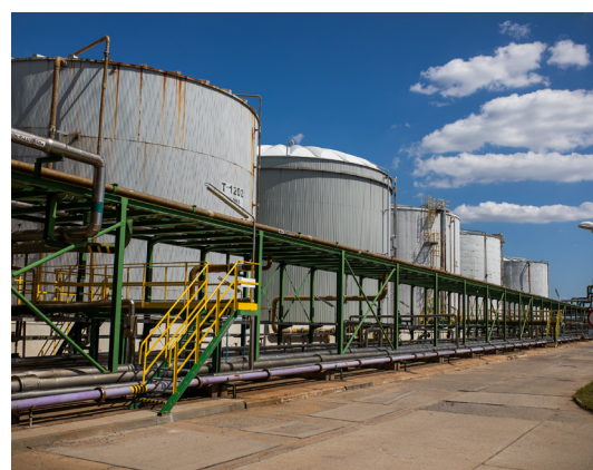
ZBIORNIKI NA TERENIE ZAKŁADU POLICHLORKU WINYLU - DZIŚ
