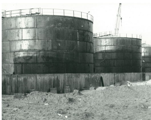
ZBIORNIKI NA TERENIE ZAKŁADU POLICHLORKU WINYLU - WCZORAJ
